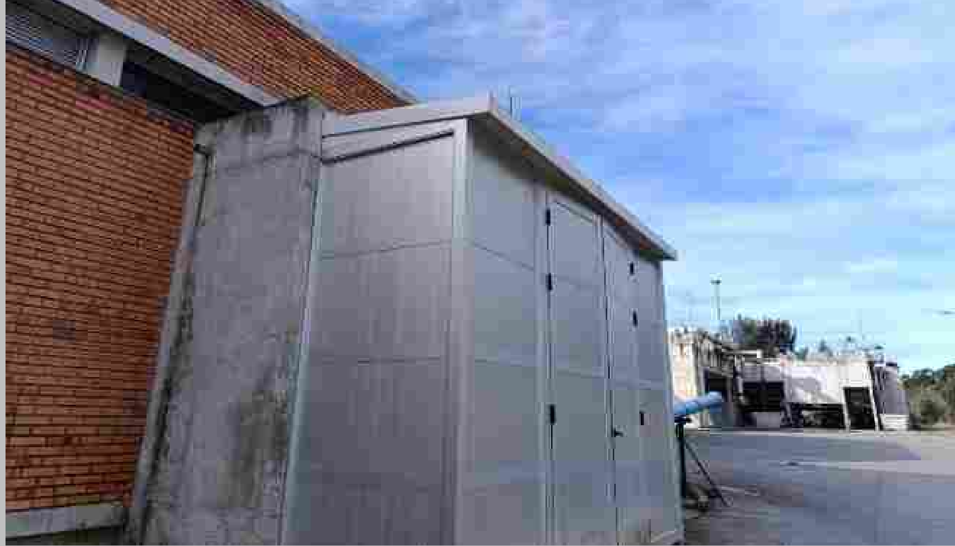
Sala de Centrífugas
